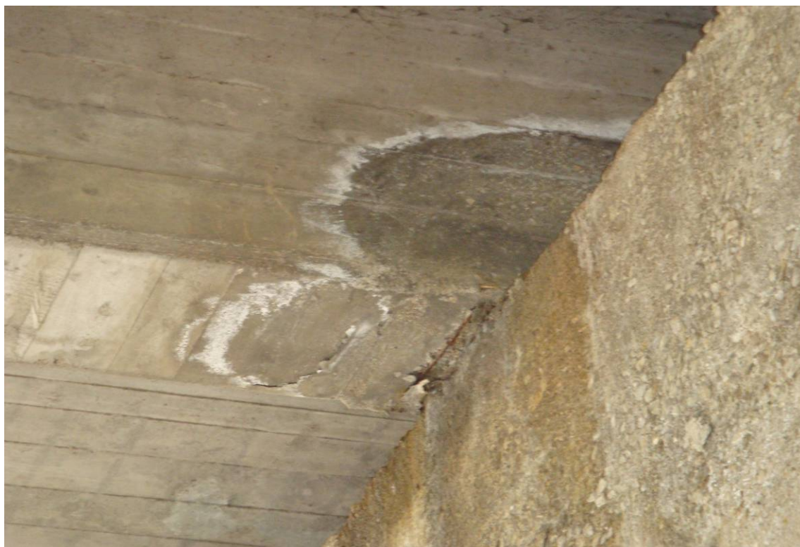
Foto 6 – Particolare intradosso impalcato – appoggio trave
