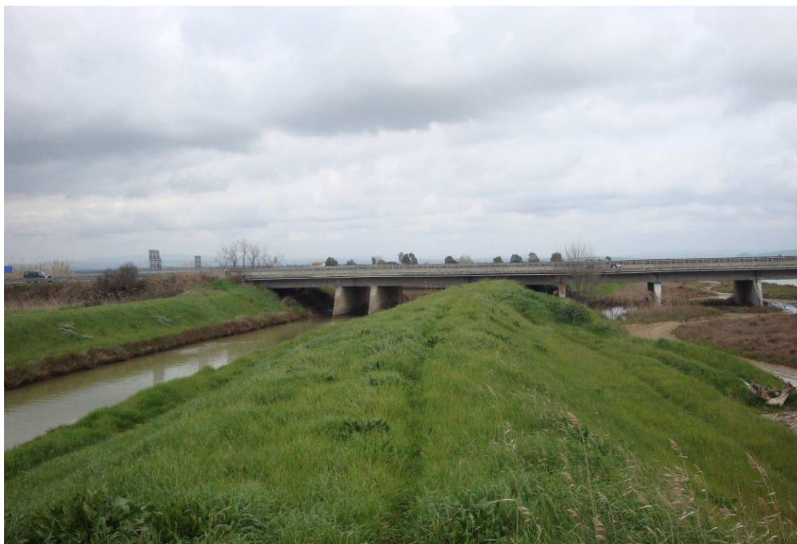
Foto 2 – Vista laterale da valle – campate sul canale nord
