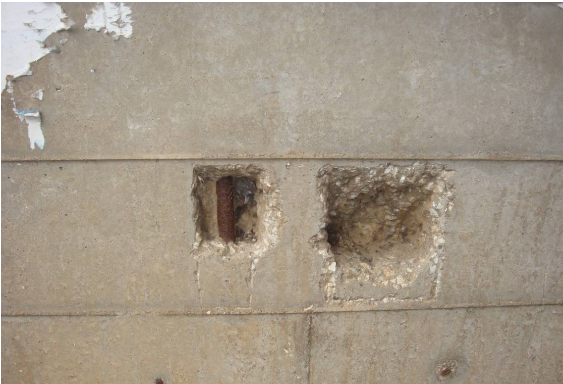
Foto 6 – Particolare saggi conoscitivi sulle spalle
