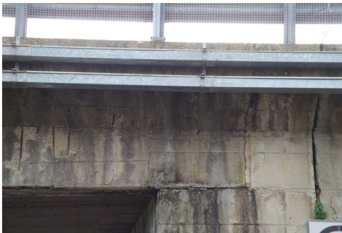
Foto 8 – Particolare appoggio trave di bordo
