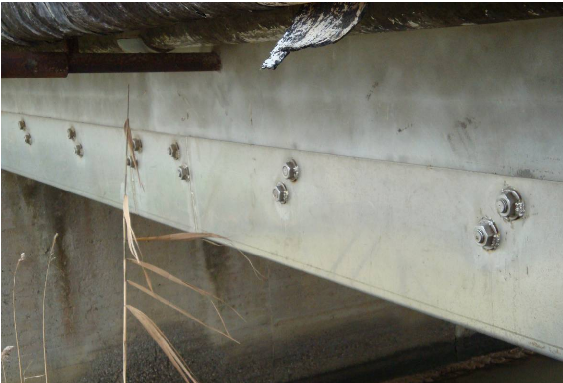
Foto 9 – particolare placcaggio trave
