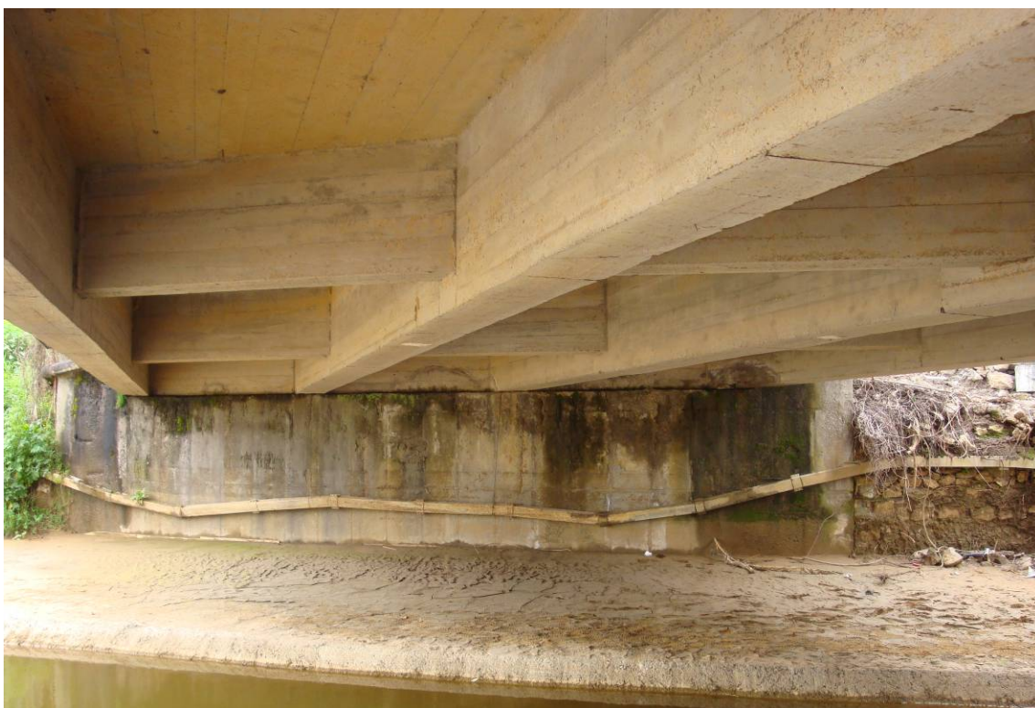
Foto 6 – Vista intradosso impalcato monte, campata sud
