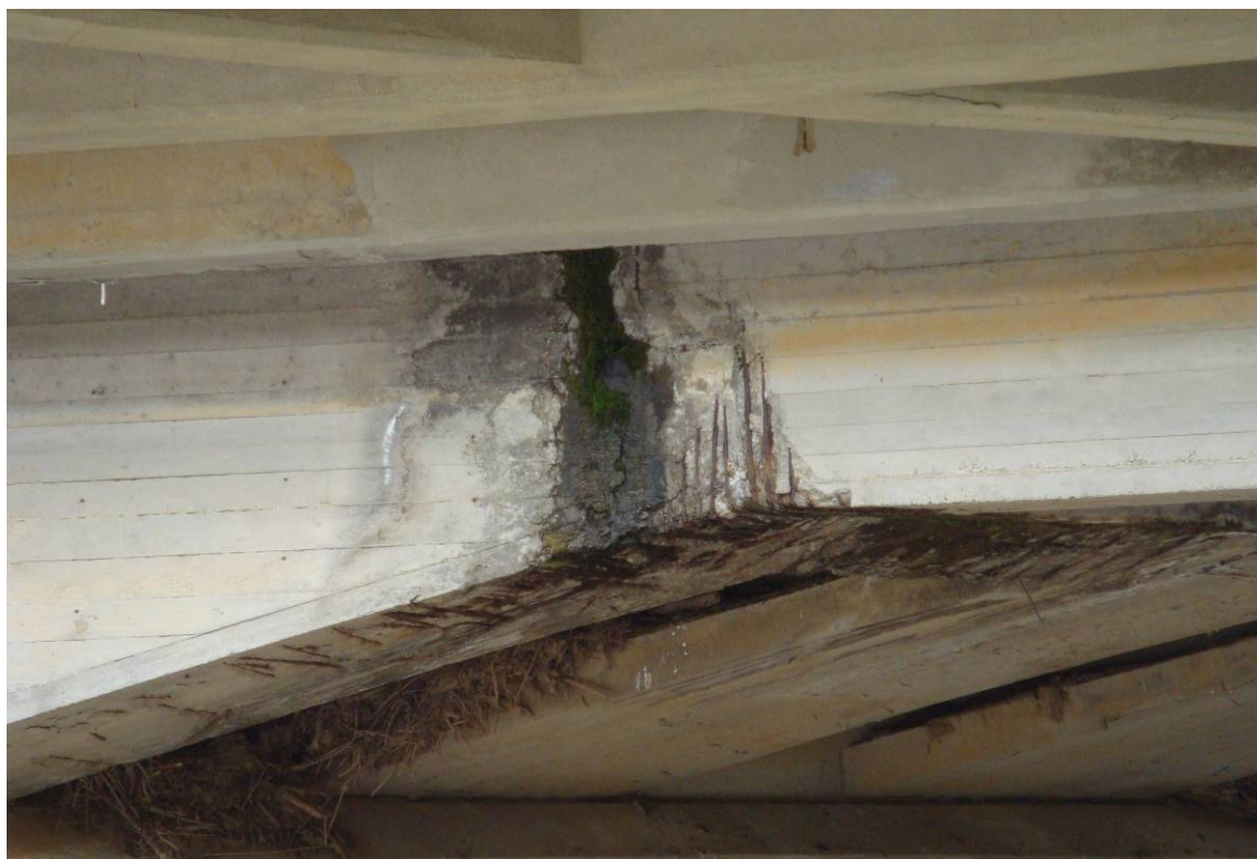
Foto 11 – Particolare seggiola gerber impalcato monte
