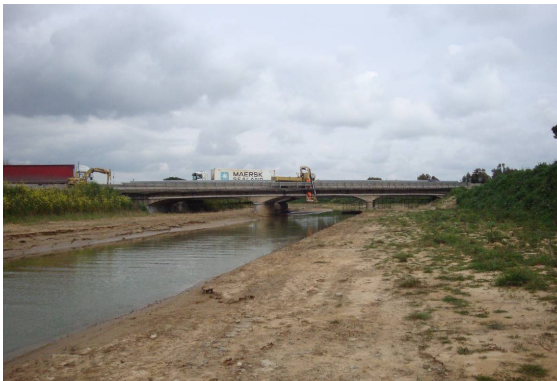
Foto 3 – Vista laterale da valle
