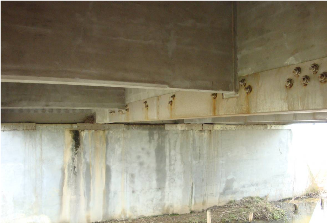
Foto 8 – Vista intradosso – placcaggio trave
