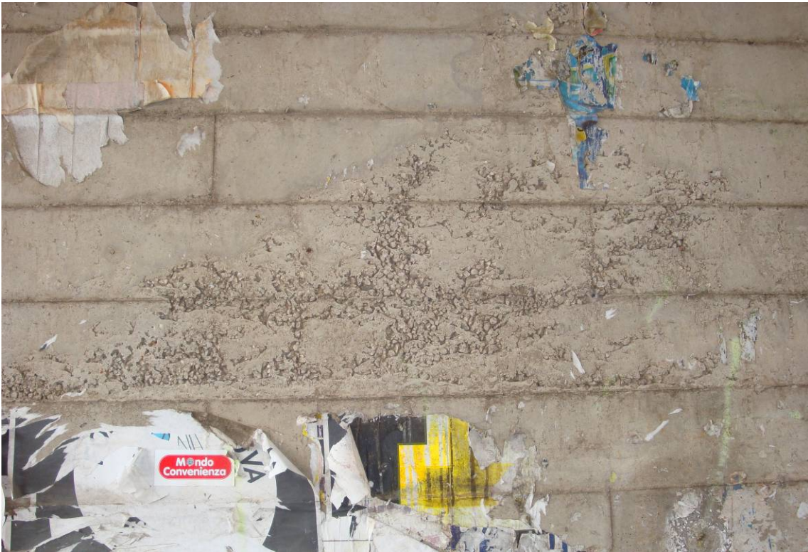
Foto 5 – Vespaio sul muro frontale della spalla
