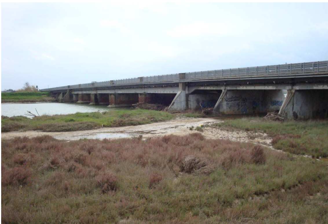
Foto 3 – Vista laterale da monte
