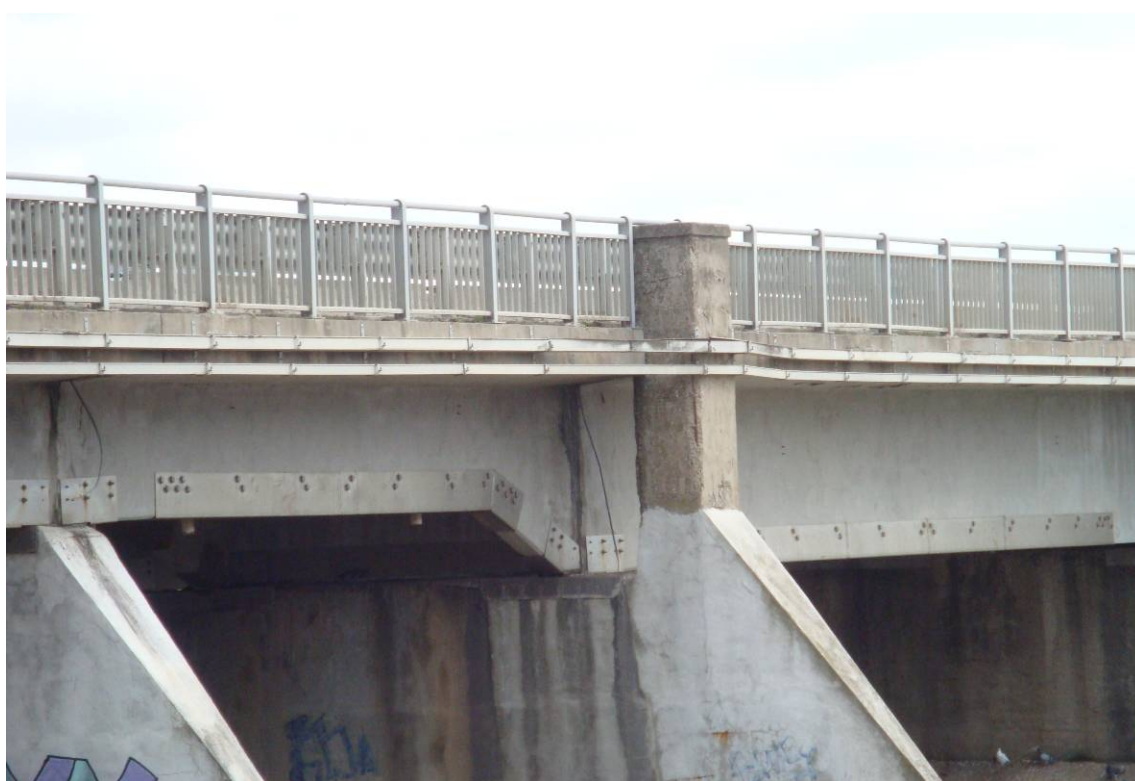
Foto 6 – Vista laterale da valle – particolare placcaggio travi
