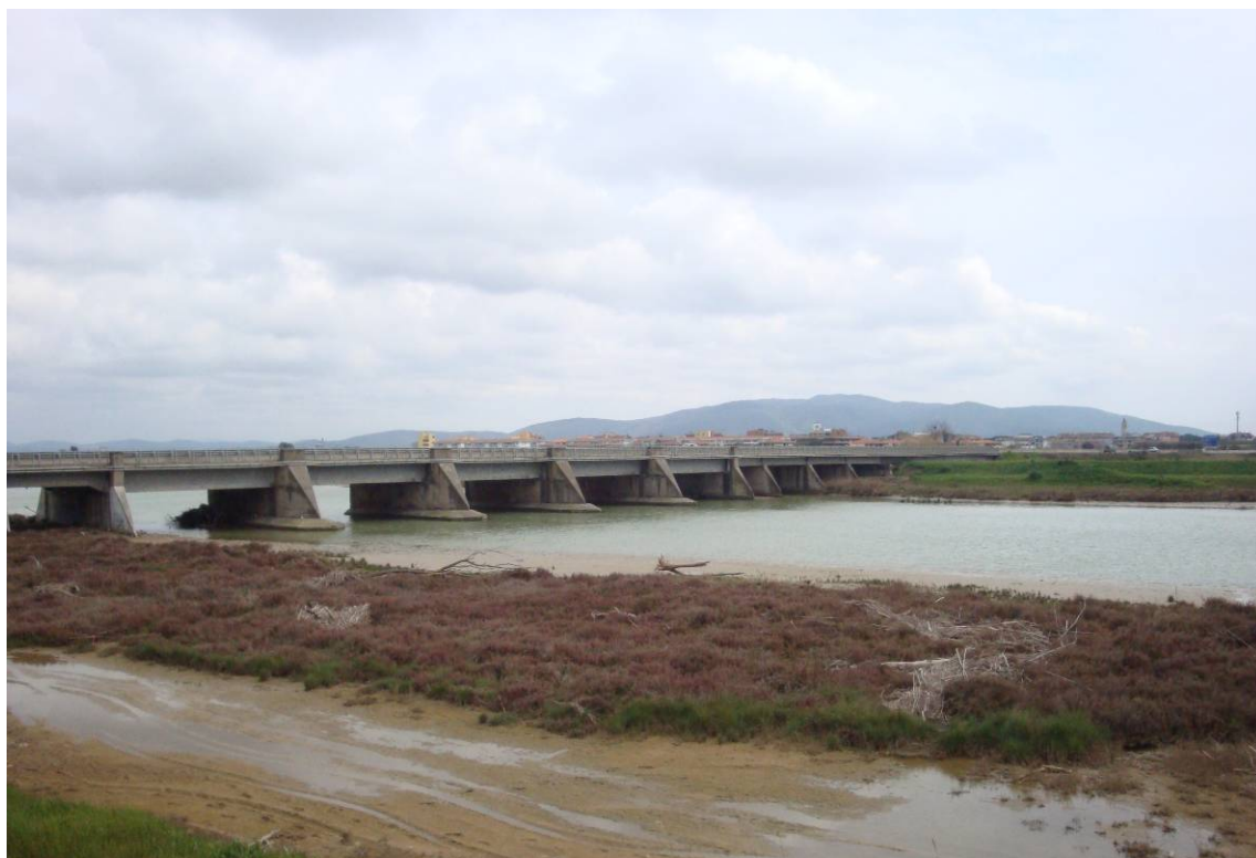
Foto 1 – Vista laterale da valle
