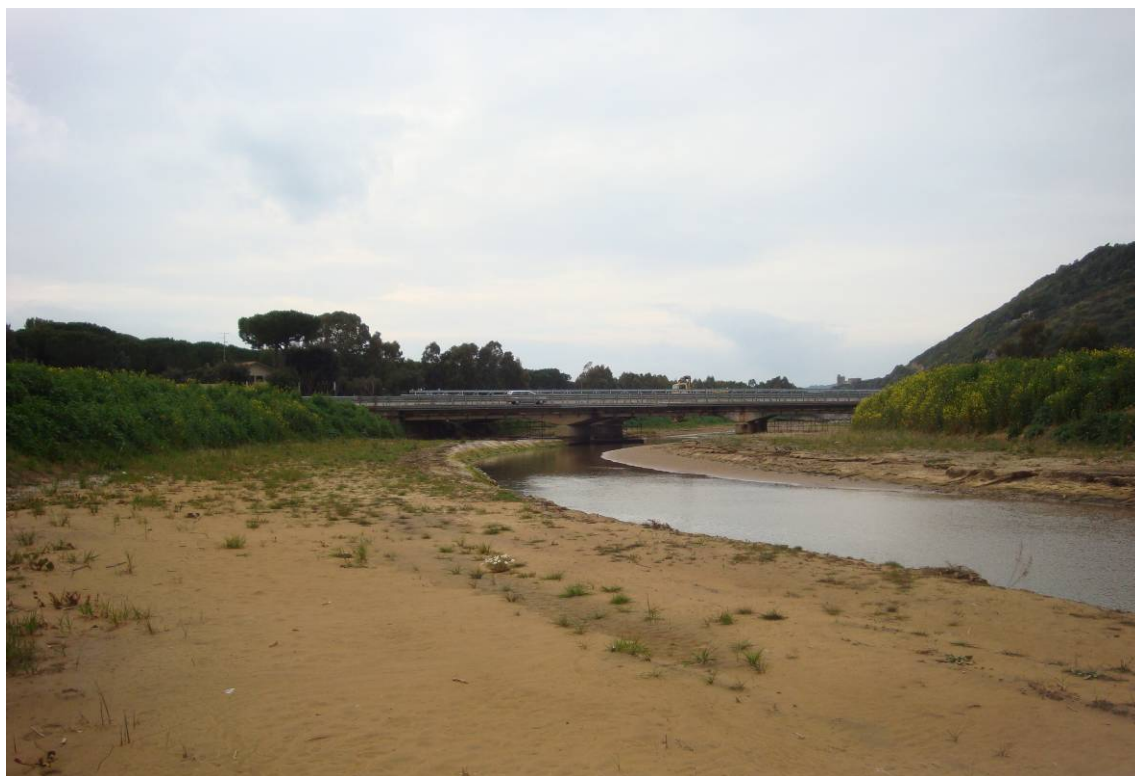
Foto 1 – Vista laterale da monte
