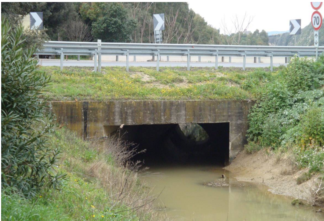
Foto 5 – Scatolare sul canale sud
