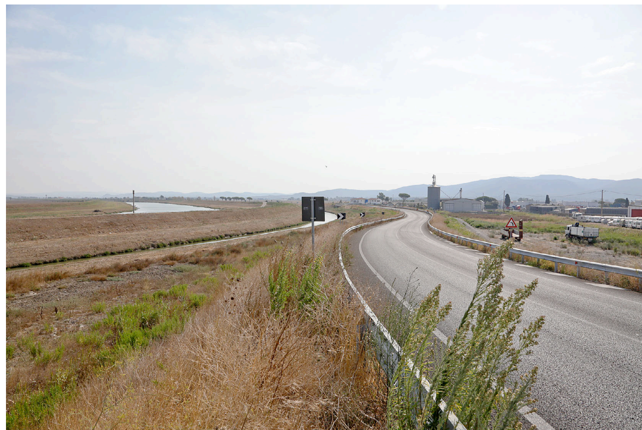
Figura 2-6 – Argine sinistro del Fiume Albegna
