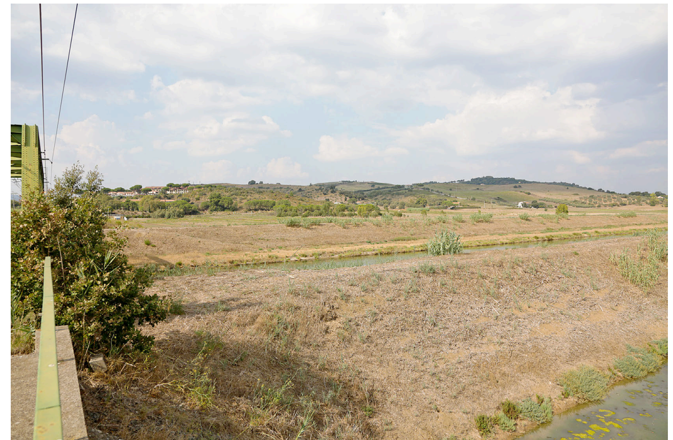
Figura 2-9 - Ponte ferroviario sull'Osa
