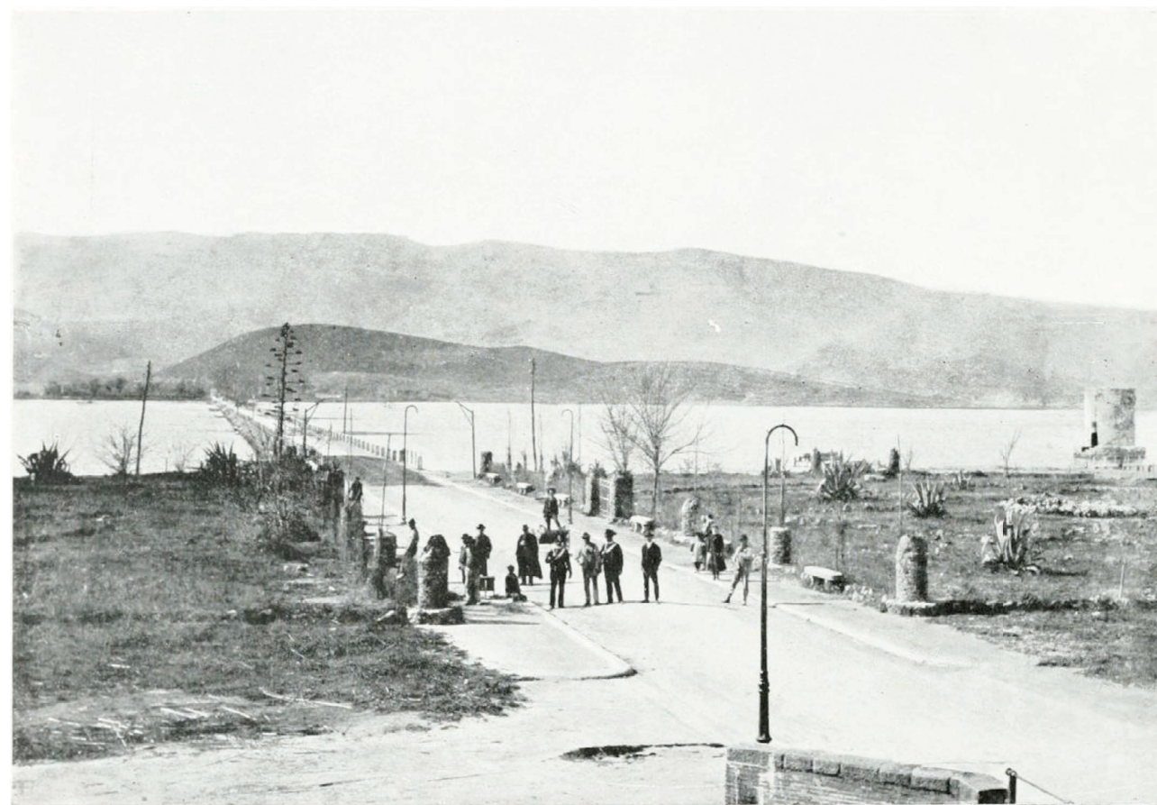
MONTE ARGENTARIO E IL PONTE-DIGA.
