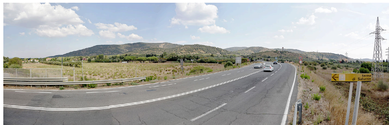
Figura 2-14 – Stato dei luoghi – Cantiere Campo Base CB01 Orbetello scalo
