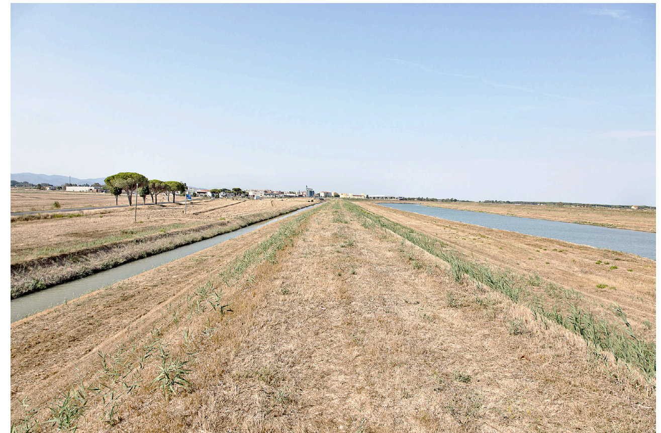
Figura 2-10 – Argine sinistro del Fiume Albegna
