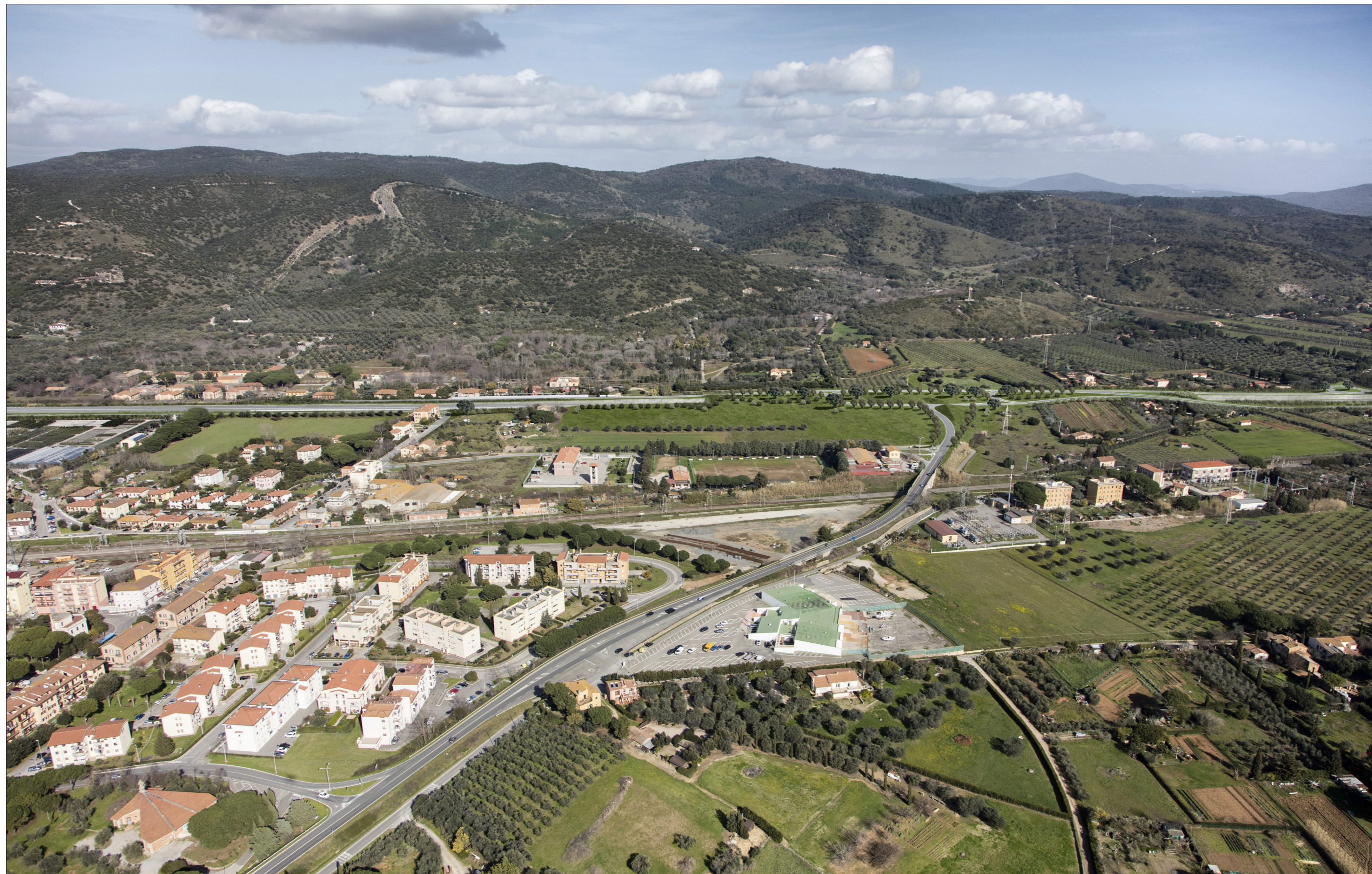
PV A4 - Nuova galleria artificiale Orbetello, svincolo di Orbetello / Monte Argentario, vista aerea - post operam
