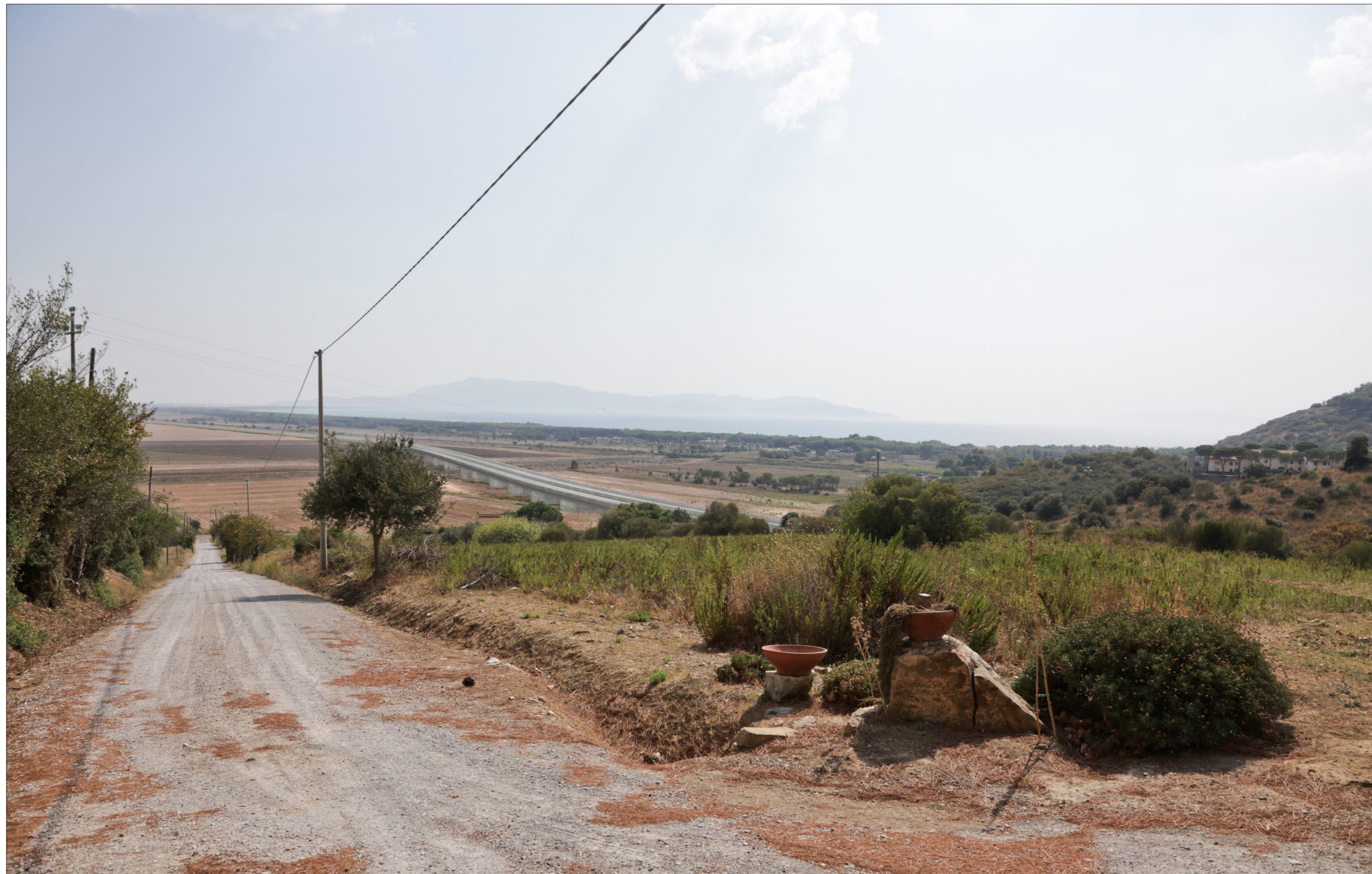
PV 21 - Nuovo ponte sul torrente Osa, vista da terra - post operam
