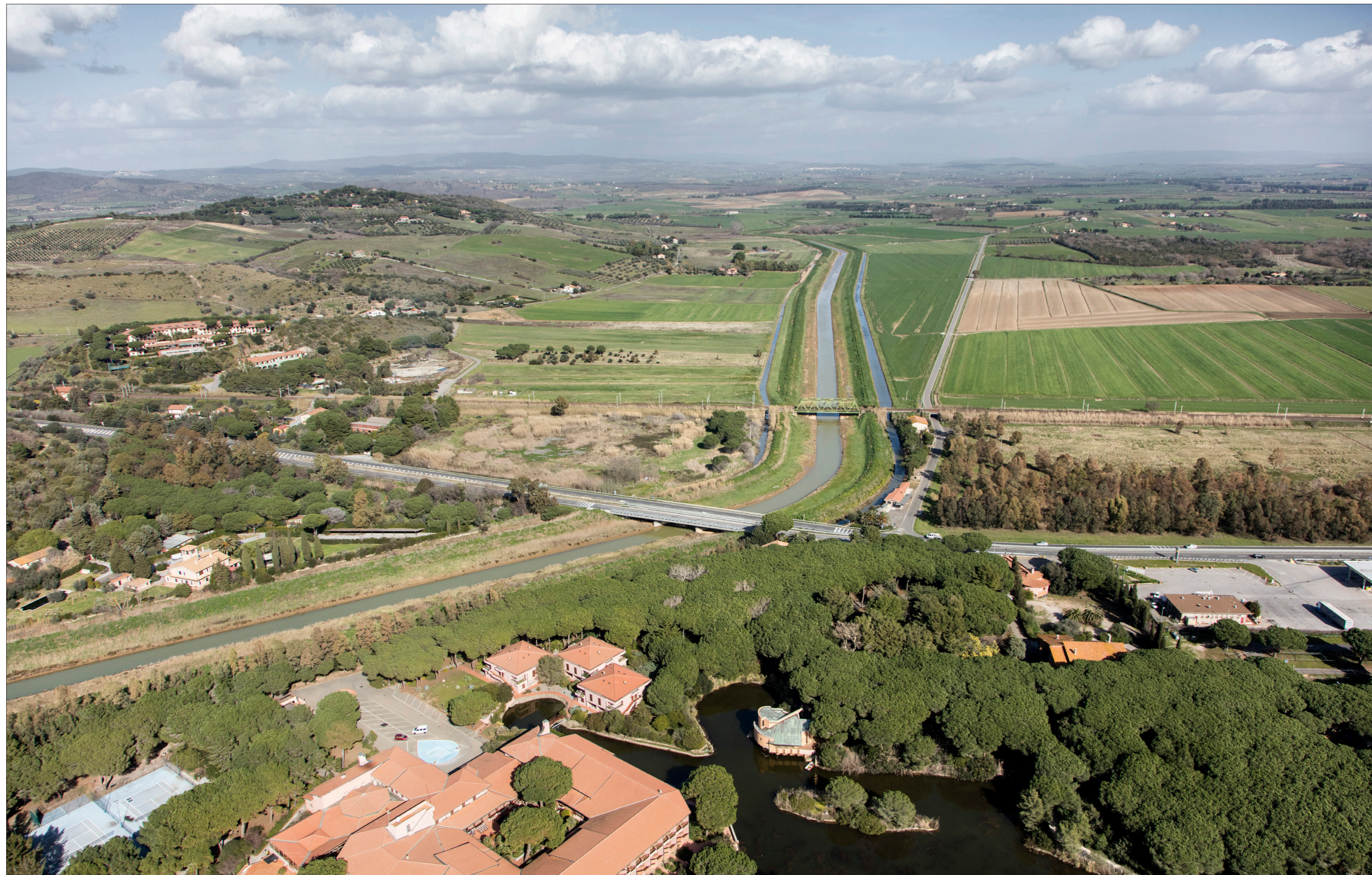
PV A2 - Galleria artificiale Fonteblanda e nuovo ponte sul torrente Osa, vista aerea - ante operam
