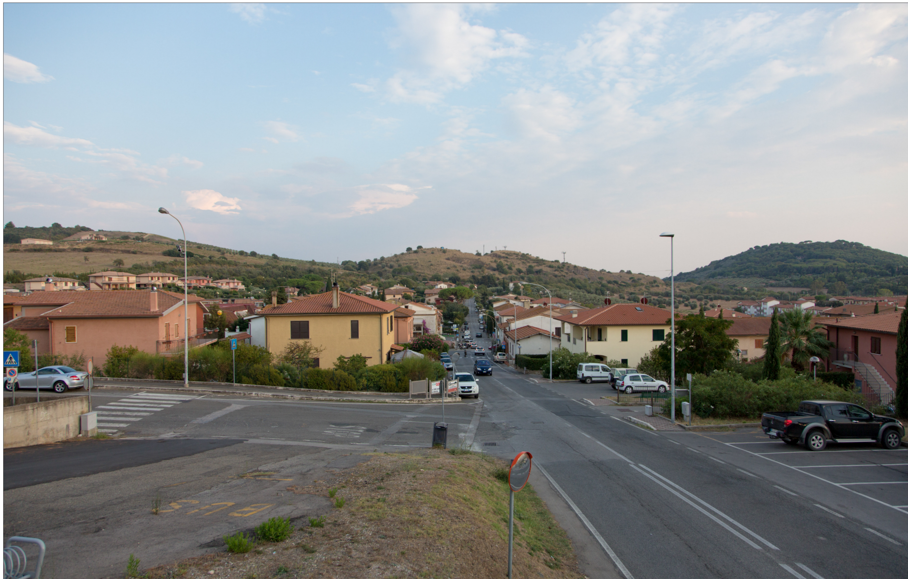
PV 17 - Località Fonteblanda, vista da terra - ante operam
