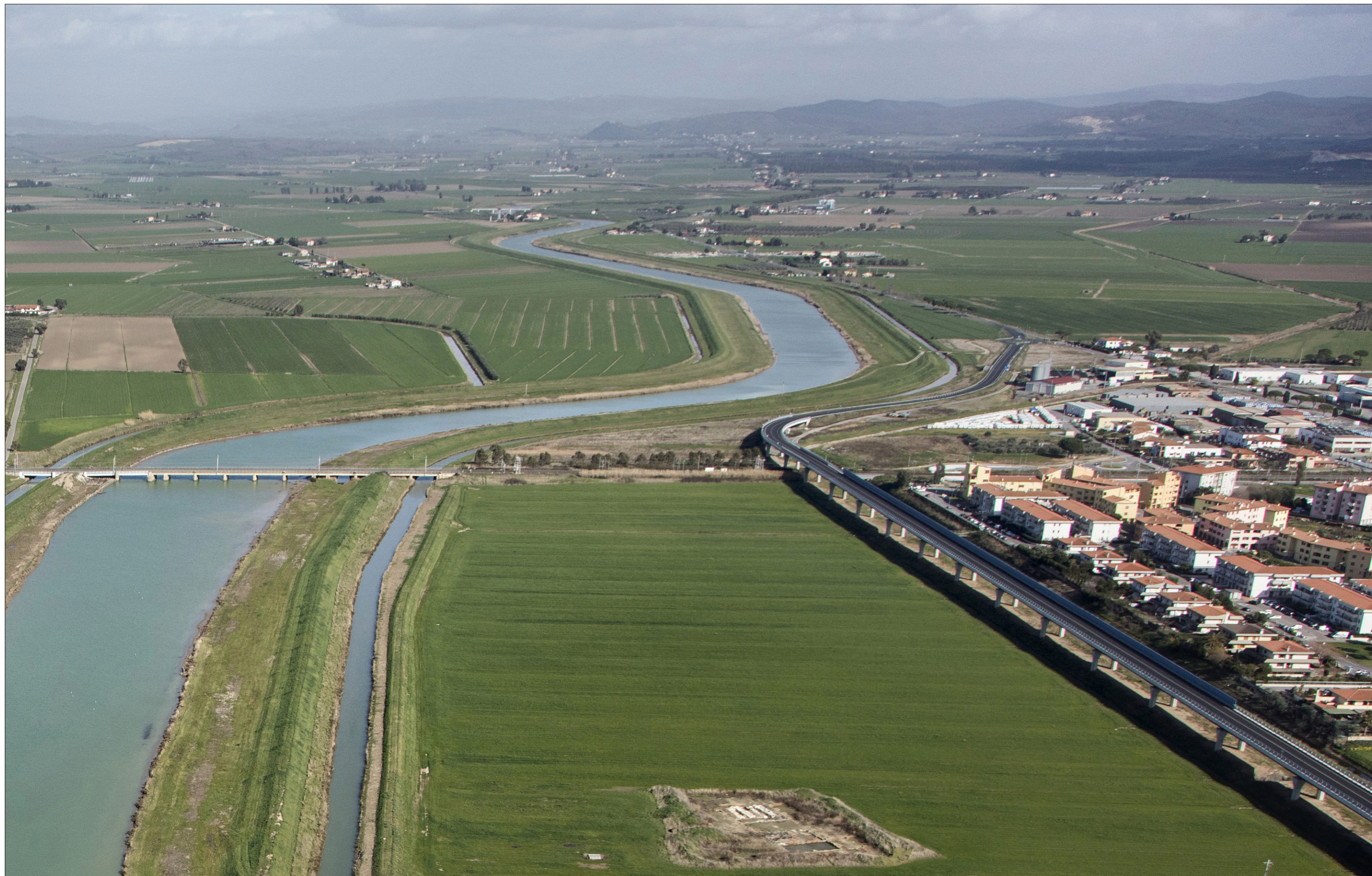
PV A3 - Località Albinia, nuovo viadotto sul Fiume Albenga, vista aerea - ante operam
