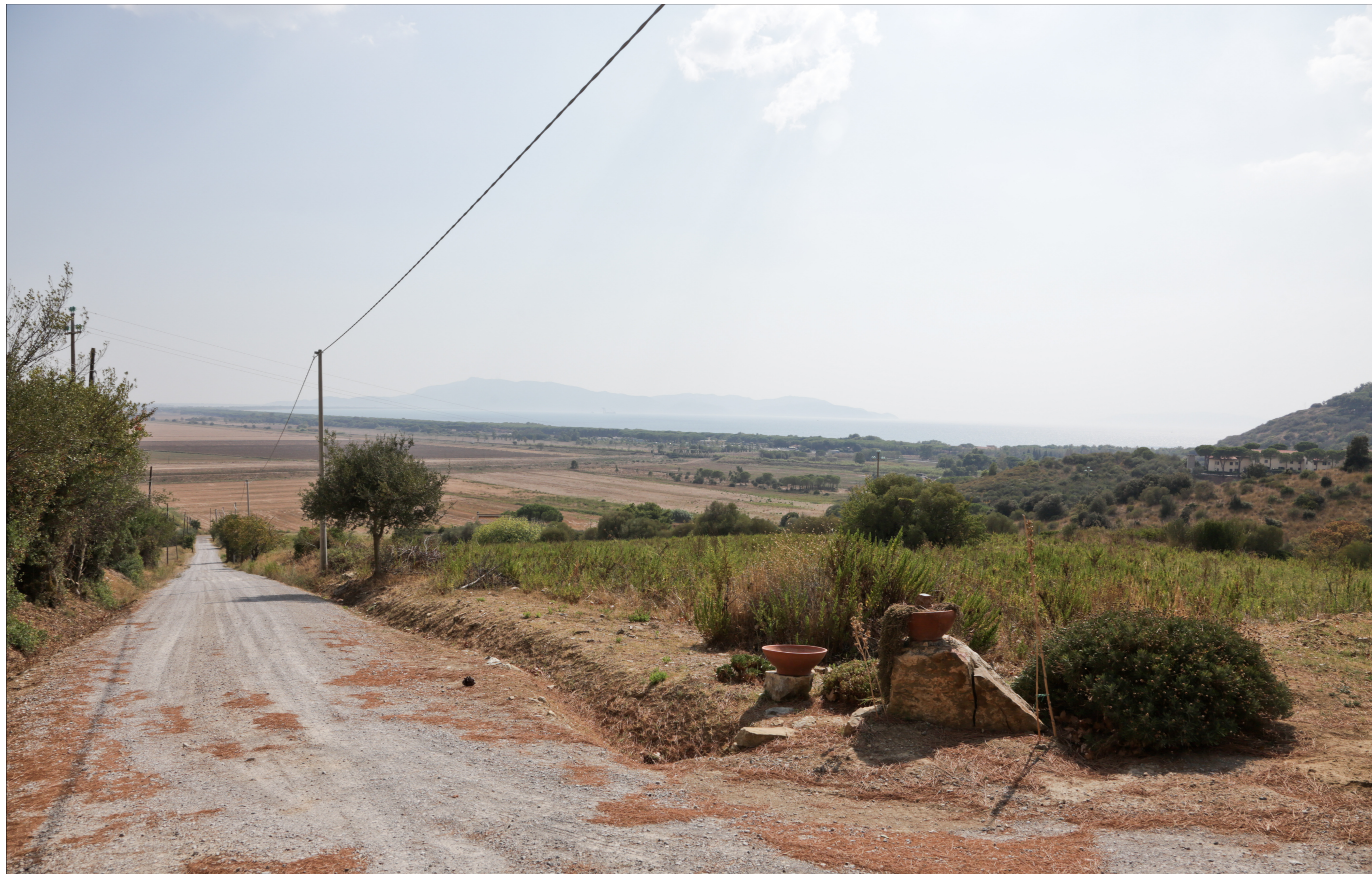
PV 21 - Nuovo ponte sul torrente Osa, vista da terra - ante operam
