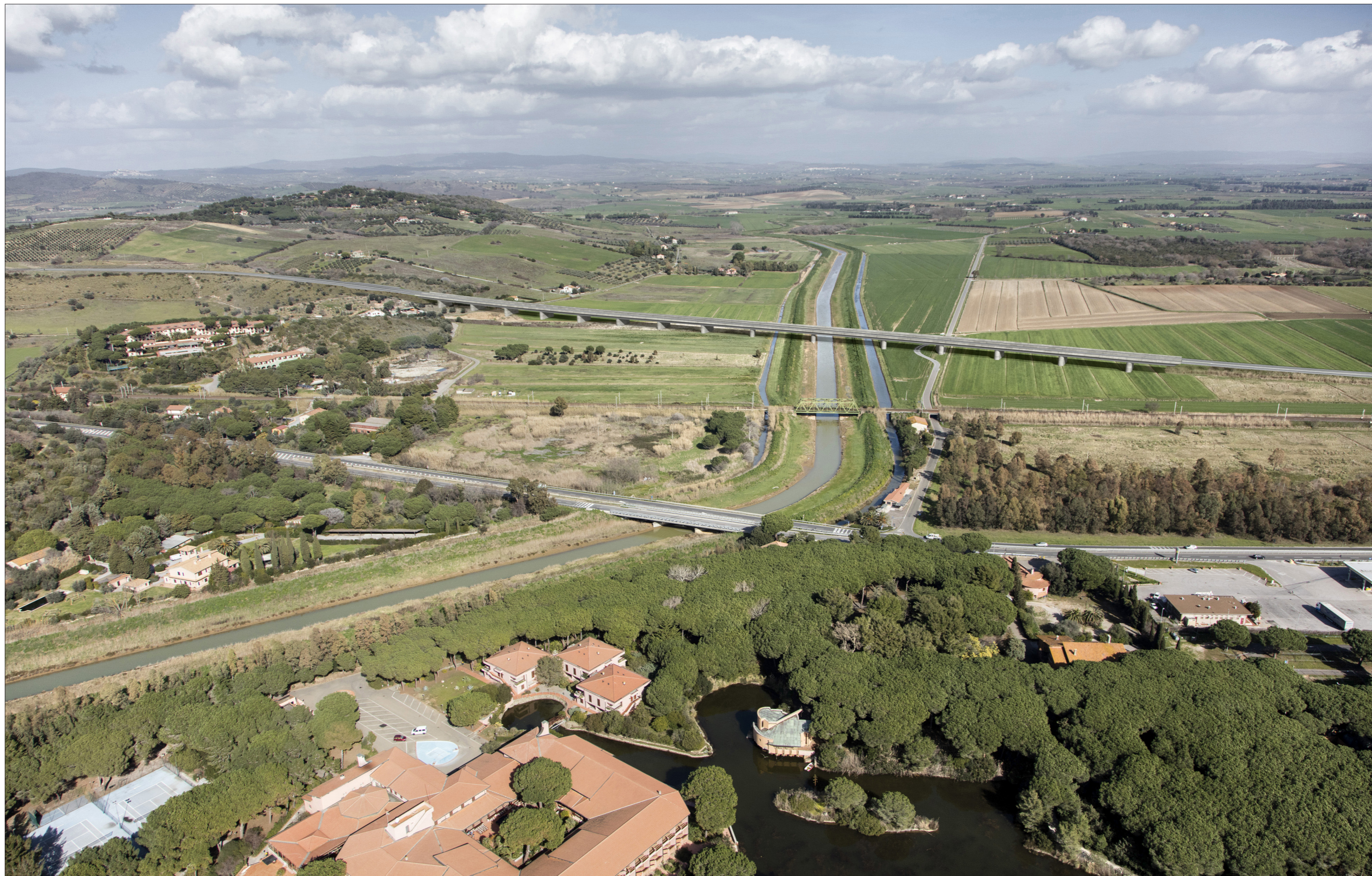
PV A2 - Galleria artificiale Fonteblanda e nuovo ponte sul torrente Osa, vista aerea - post operam
