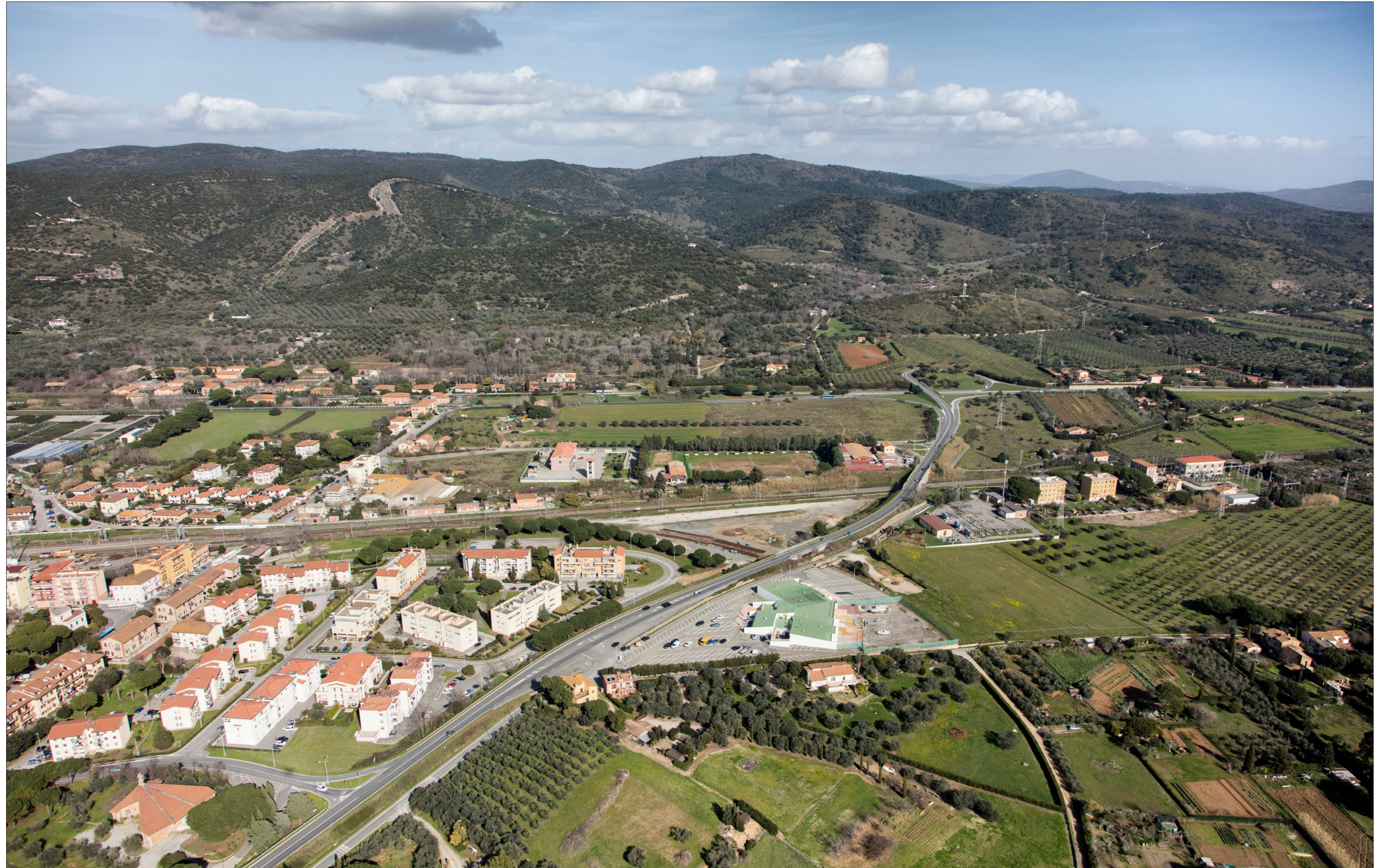
PV A4 - Nuova galleria artificiale Orbetello, svincolo di Orbetello / Monte Argentario, vista aerea - ante operam
