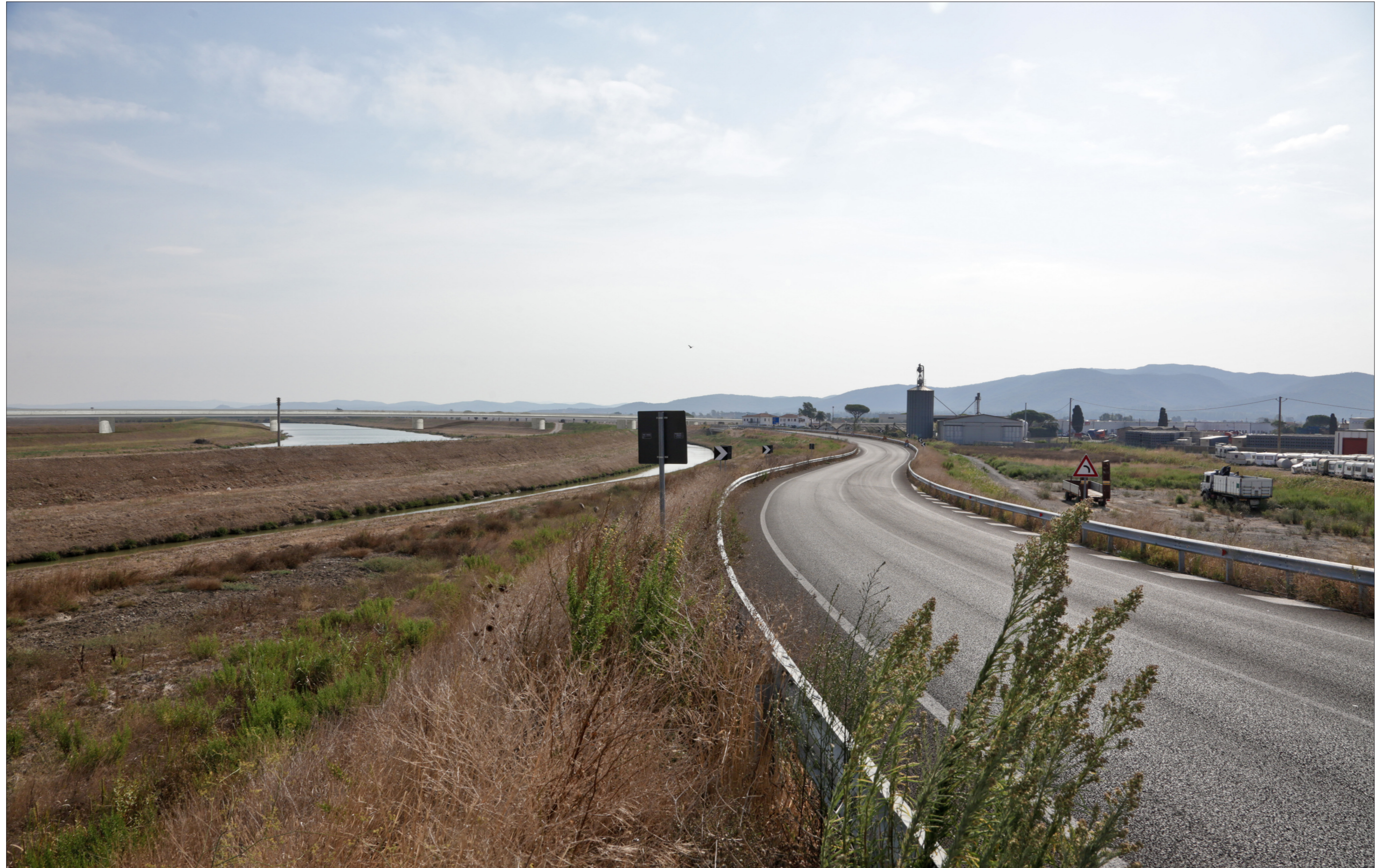
PV 34 - Località Albinia, nuovo viadotto sul Fiume Albenga, vista da terra - post operam
