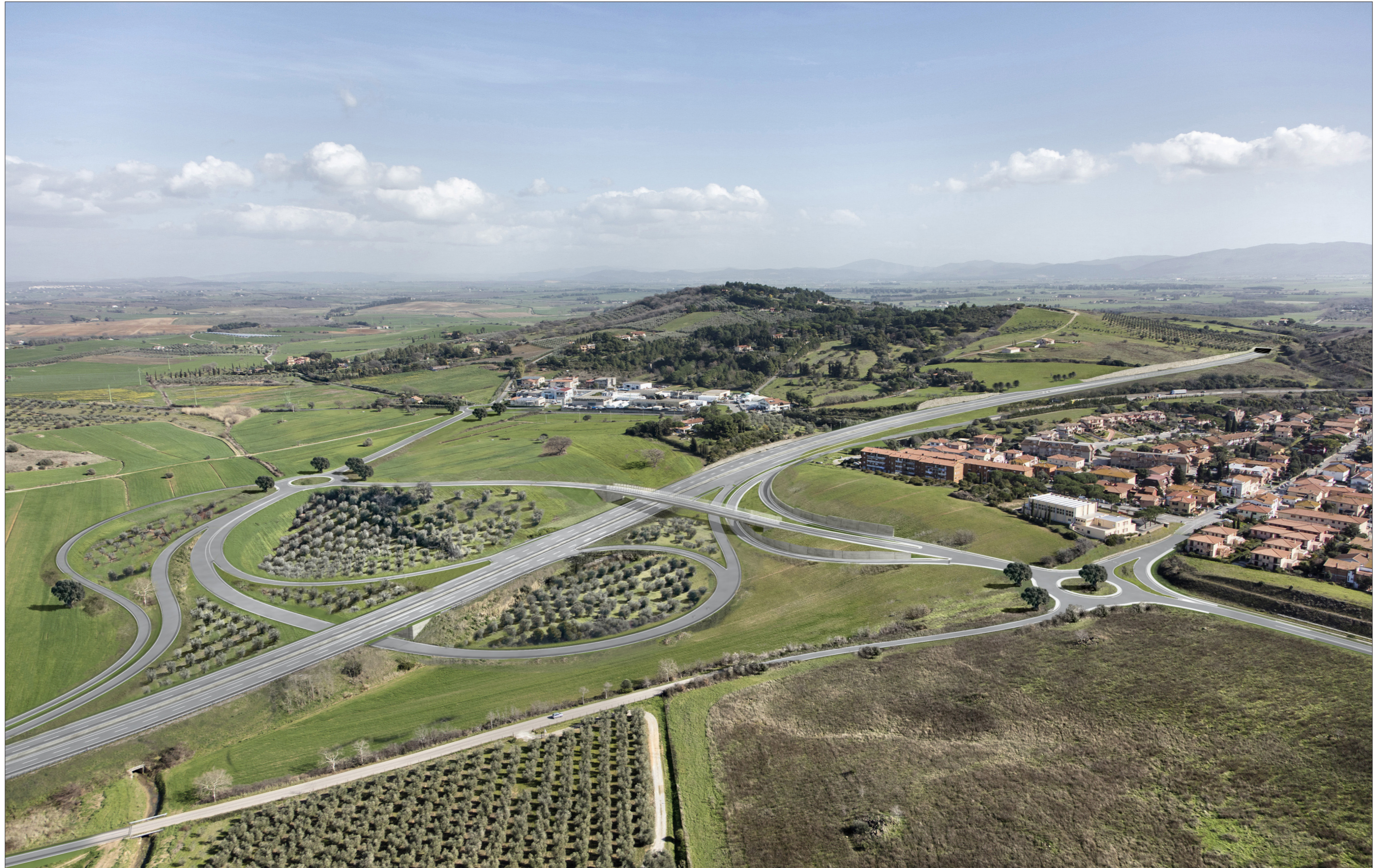
PV A1 - Località Fonteblanda, vista aerea - post operam
