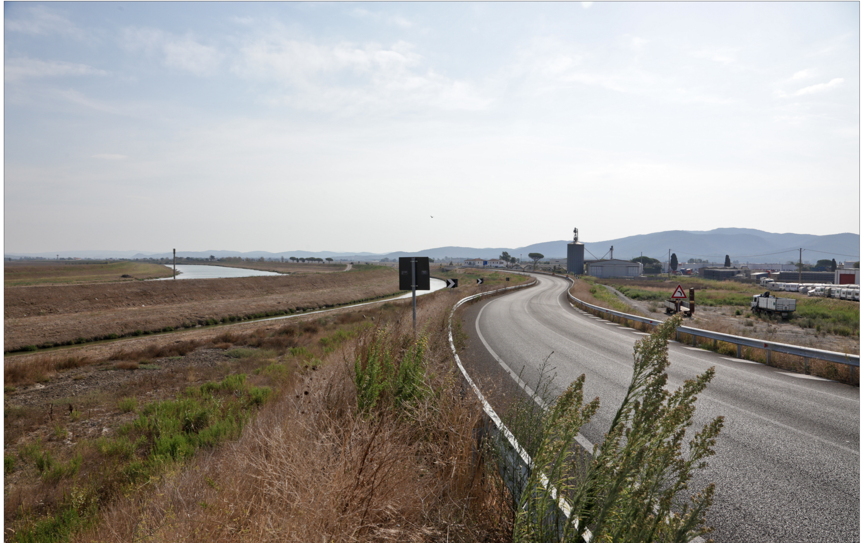
PV 34 - Località Albinia, nuovo viadotto sul Fiume Albenga, vista da terra - ante operam
