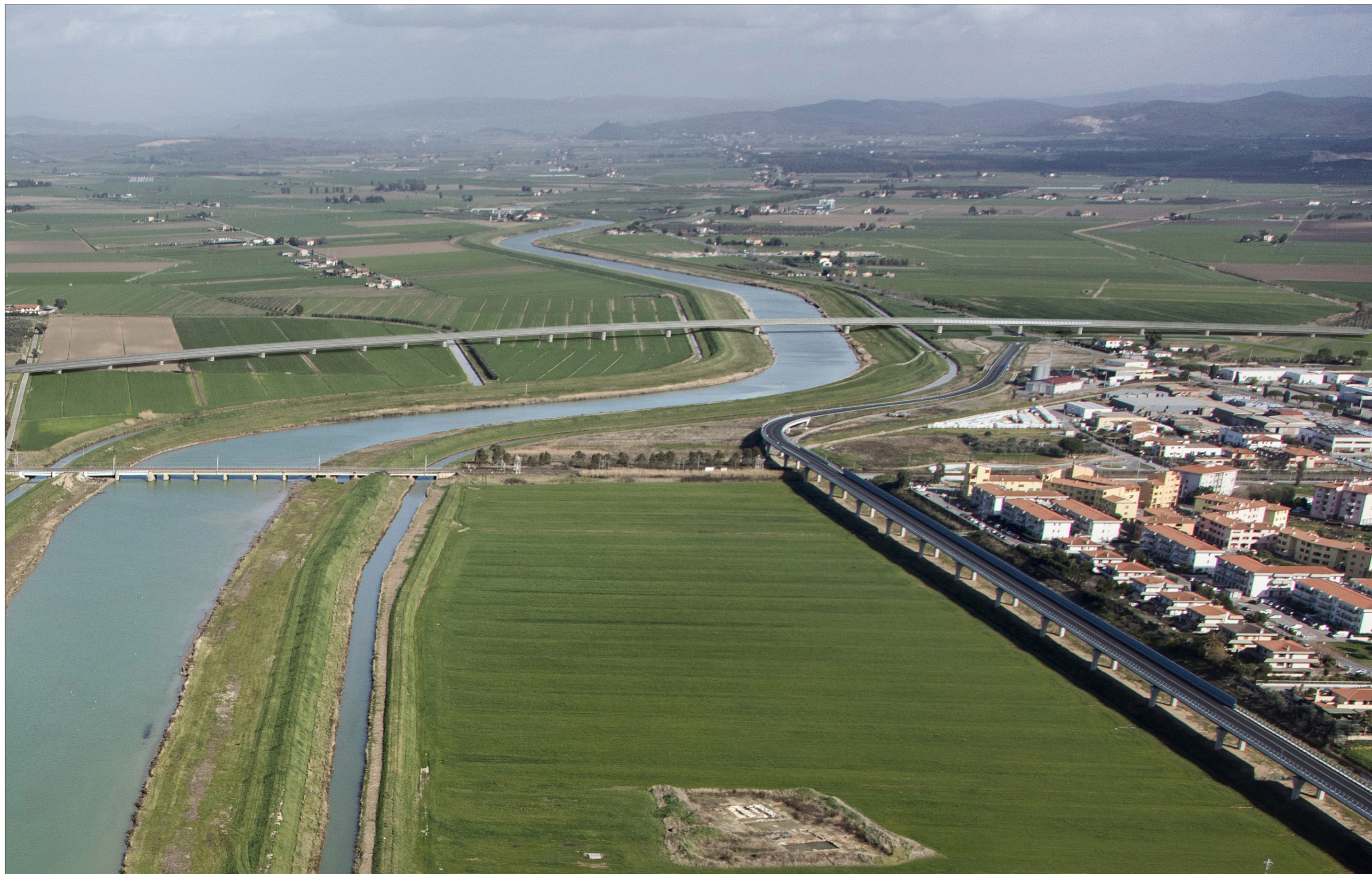
PV A3 - Località Albinia, nuovo viadotto sul Fiume Albenga, vista aerea - post operam
