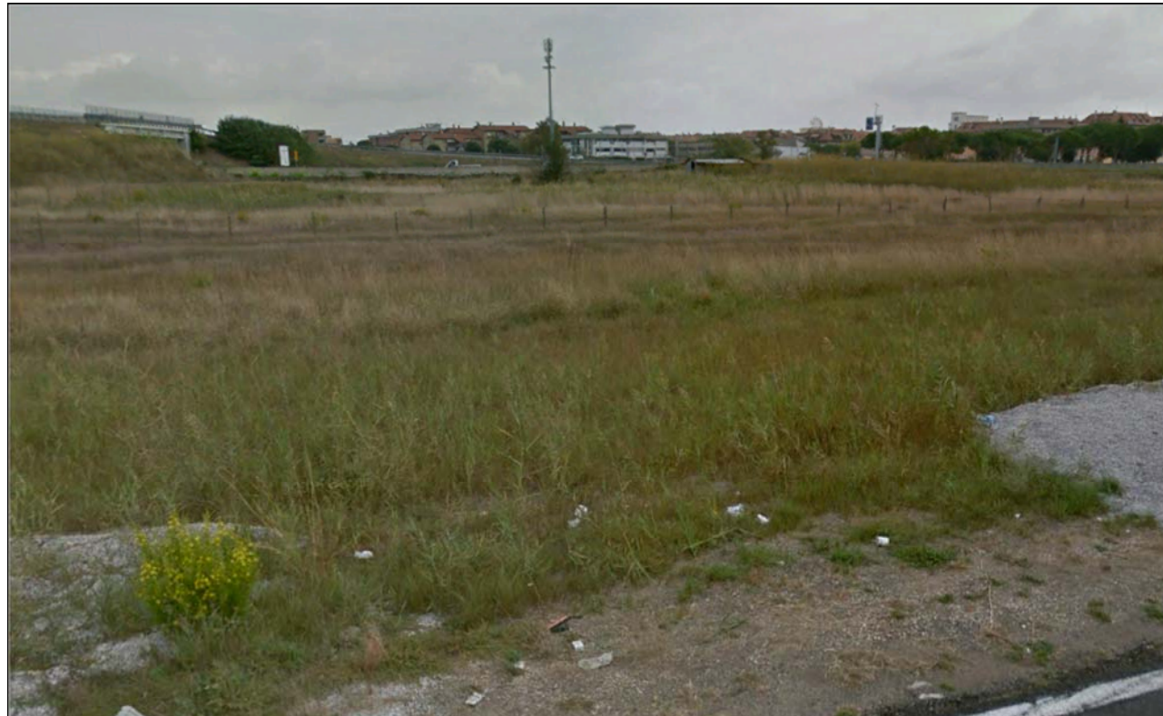
Il punto di rilievo si colloca in nei pressi dello Svincolo di Albinia dell'attuale Aurelia. In questo tratto l'attuale progetto prevede la traslazione verso l'entroterra, annullando il rischio di interferenza con l'habitat 1410 di cui al rilievo 5.3, già frammentato dalla viabilità presente nelle vicine dell'area di saggio.
