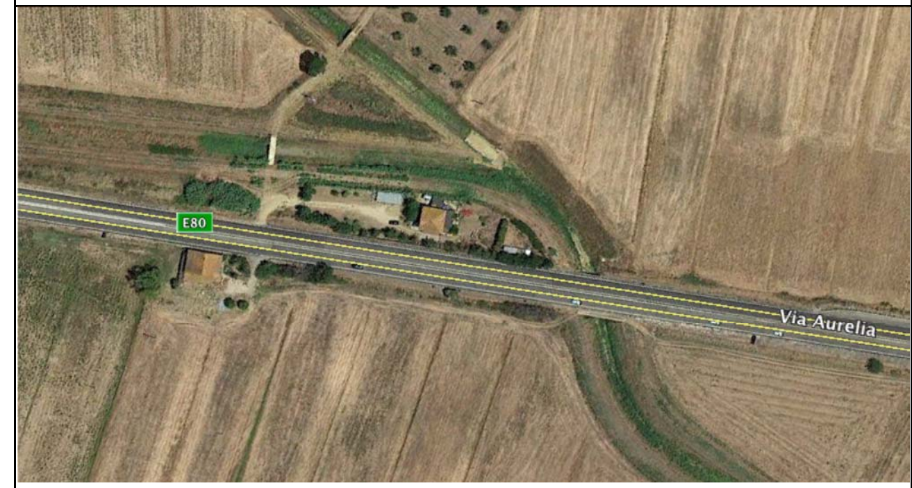
Collettore Orientale (attraversato alla progressiva 1+080 ca), attraversato in corrispondenza dell'attuale ponte della SS1 Aurelia.
