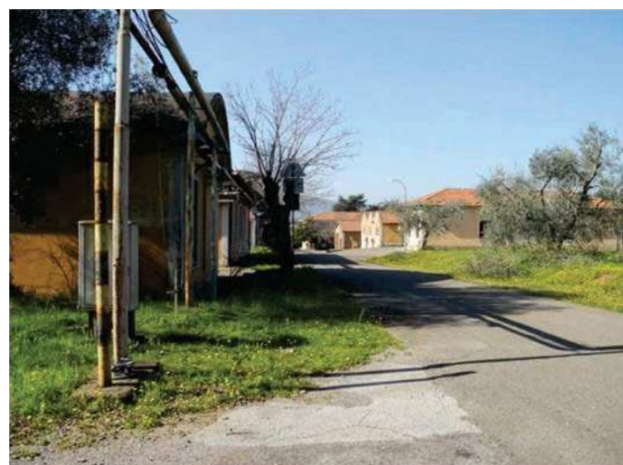
3 - 4 -viabilità interna all'area e alcune tipologie di edifici dismessi
