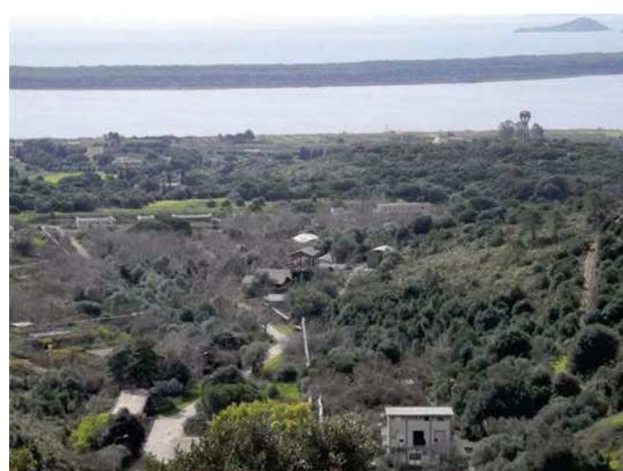
1 - vista dall'alto e verso sud dei manufatti presenti
