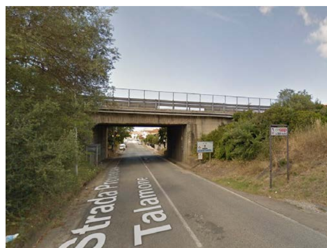
2 - Sottopasso Strada di Talamone direzione sud-ovest
