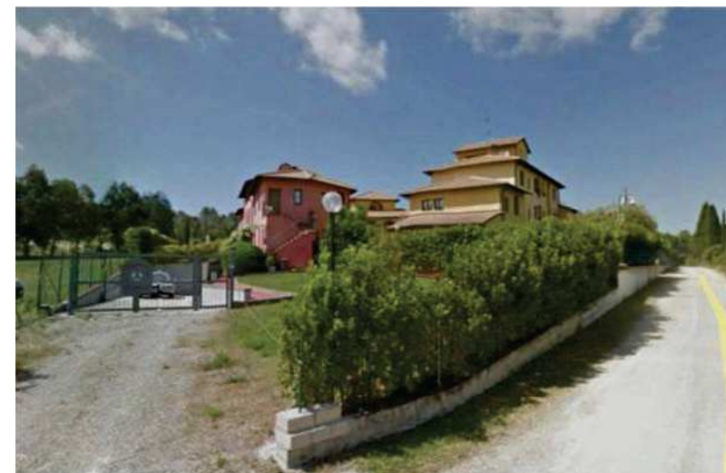
2 - Foto della struttura turistico-riettiva esistente presa dall'ingresso a nord
