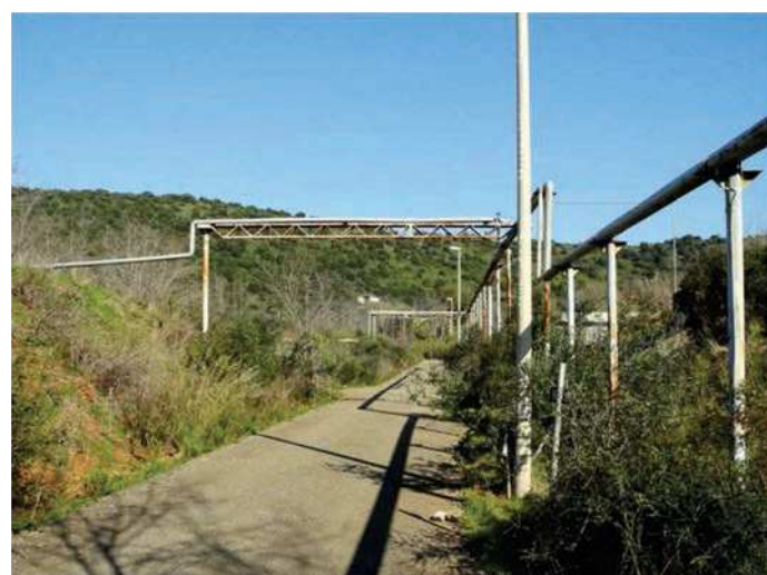
5 - 6 -percorsi interni all'area e alcune tipologie di manufatti presenti
