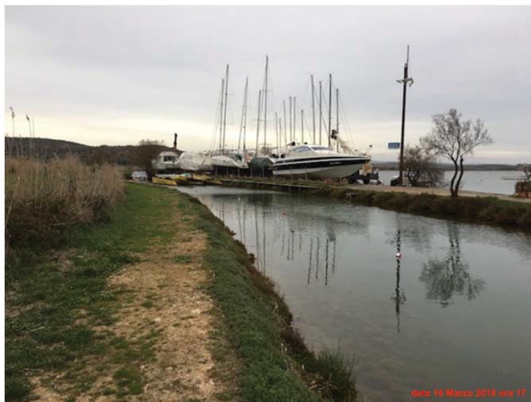
Figura 23 Panoramica della porzione interna del canale collettore usato per ormeggio imbarcazioni.
